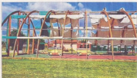
Le court couvert mis à nu pour cette rénovation spectaculaire.
